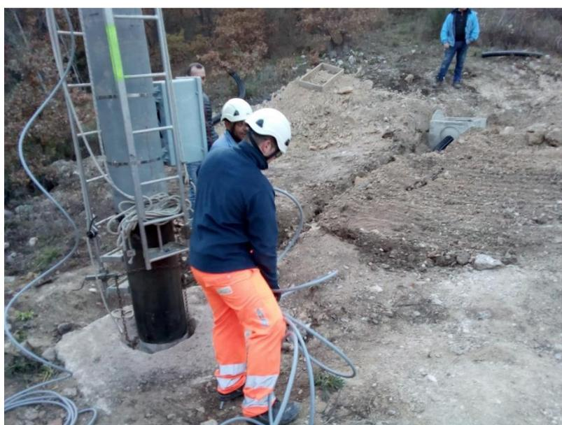
*Scavo per uscita BT interrata e posa pozzetto*
