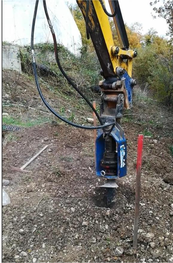
***Realizzazione buca per palo direttamente infisso tramite trivella***
