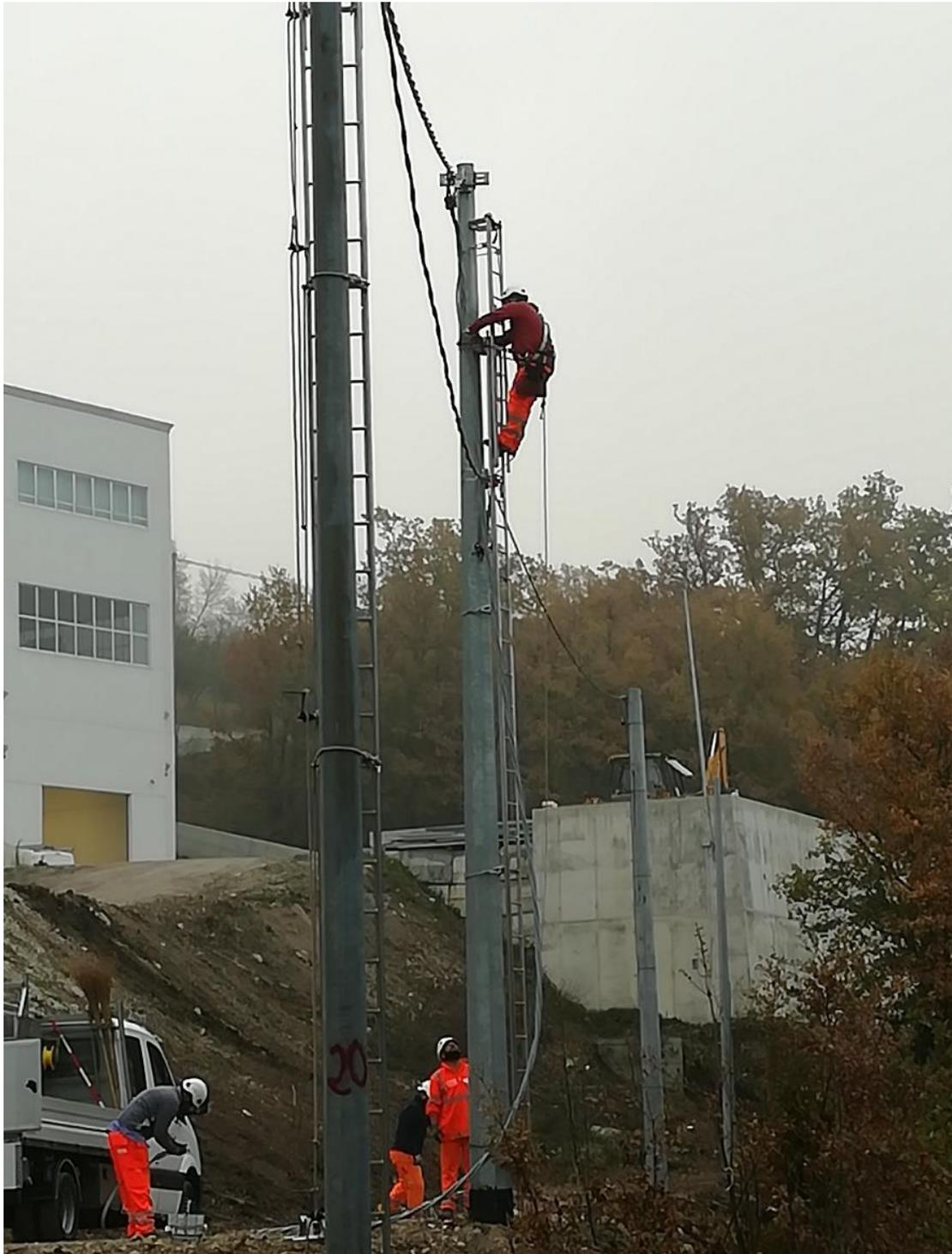
*Tesatura cavo precordato BT su sostegni*
