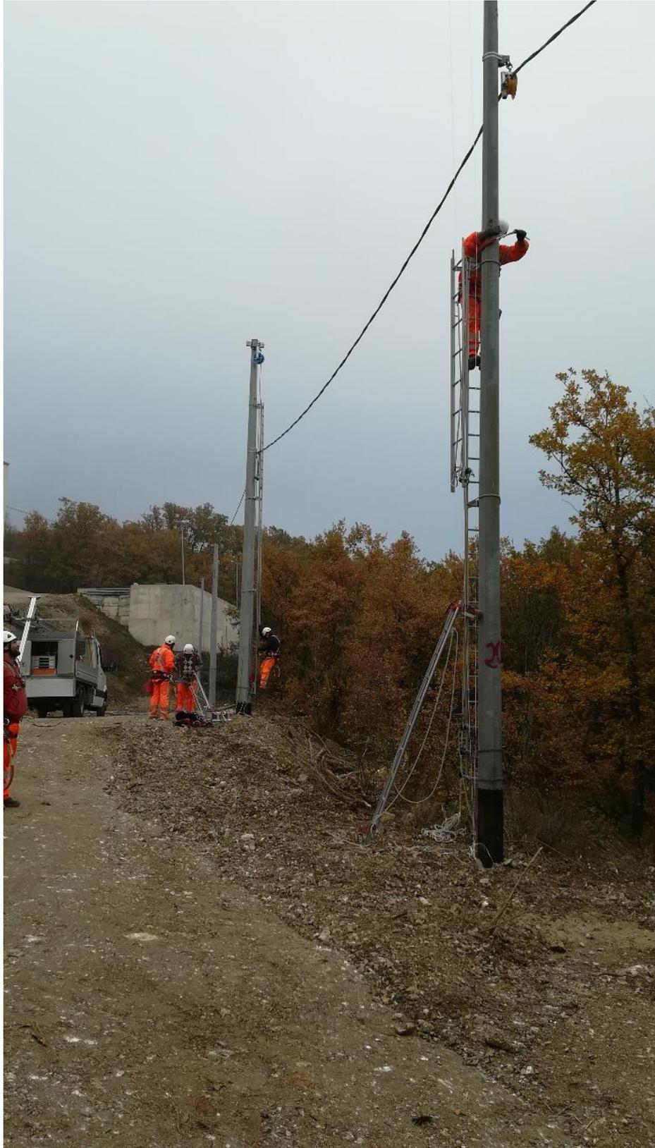
*Tesatura cavo precordato BT su sostegni*
