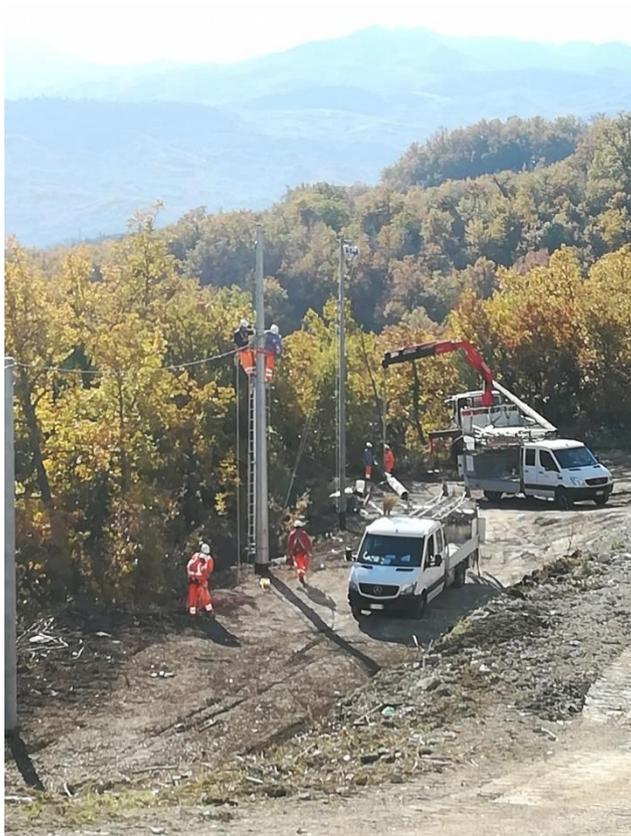
***Tesatura cavo precordato BT su sostegni***
