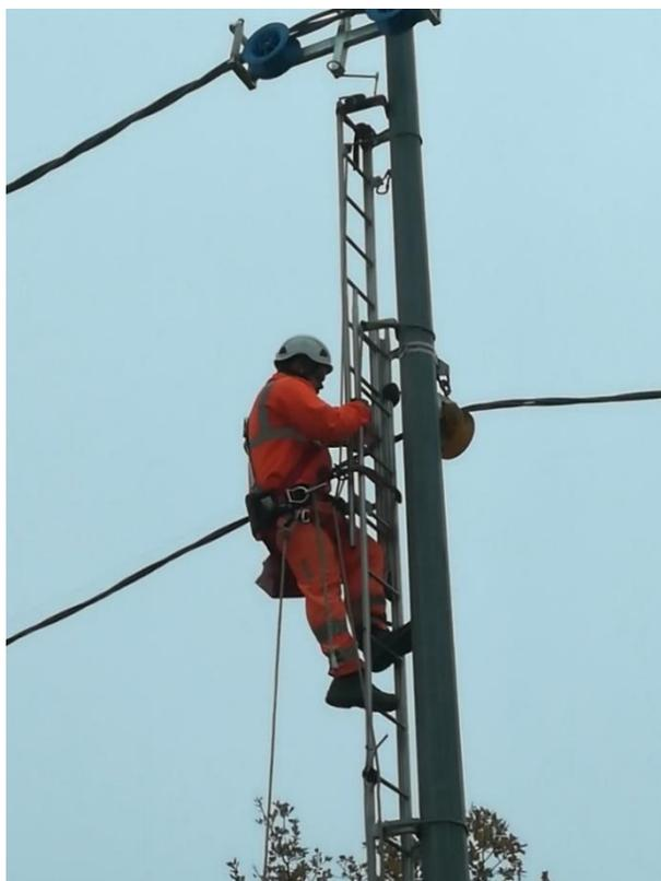
***Tesatura cavo precordato BT su sostegni***
