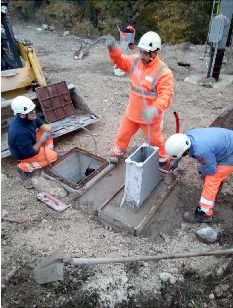
*Posa nodo di derivazione C3M con infilaggio cavi BT*
