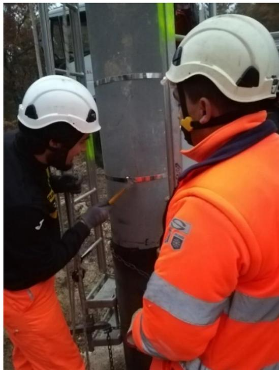
*Fissaggio armadetto su PTP con nastro di acciaio tipo bandit*
