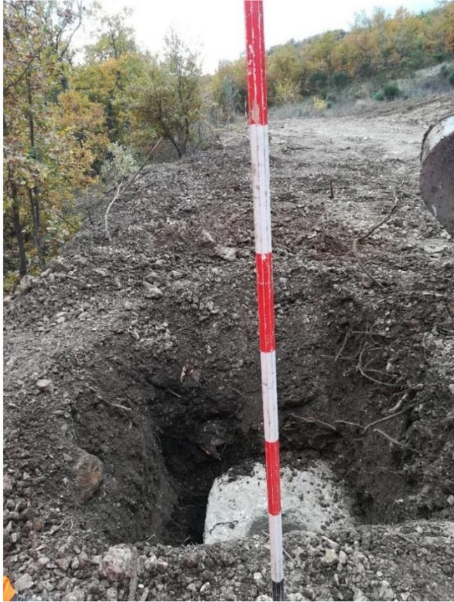
*Costipamento blocco di fondazione con allineamento*
