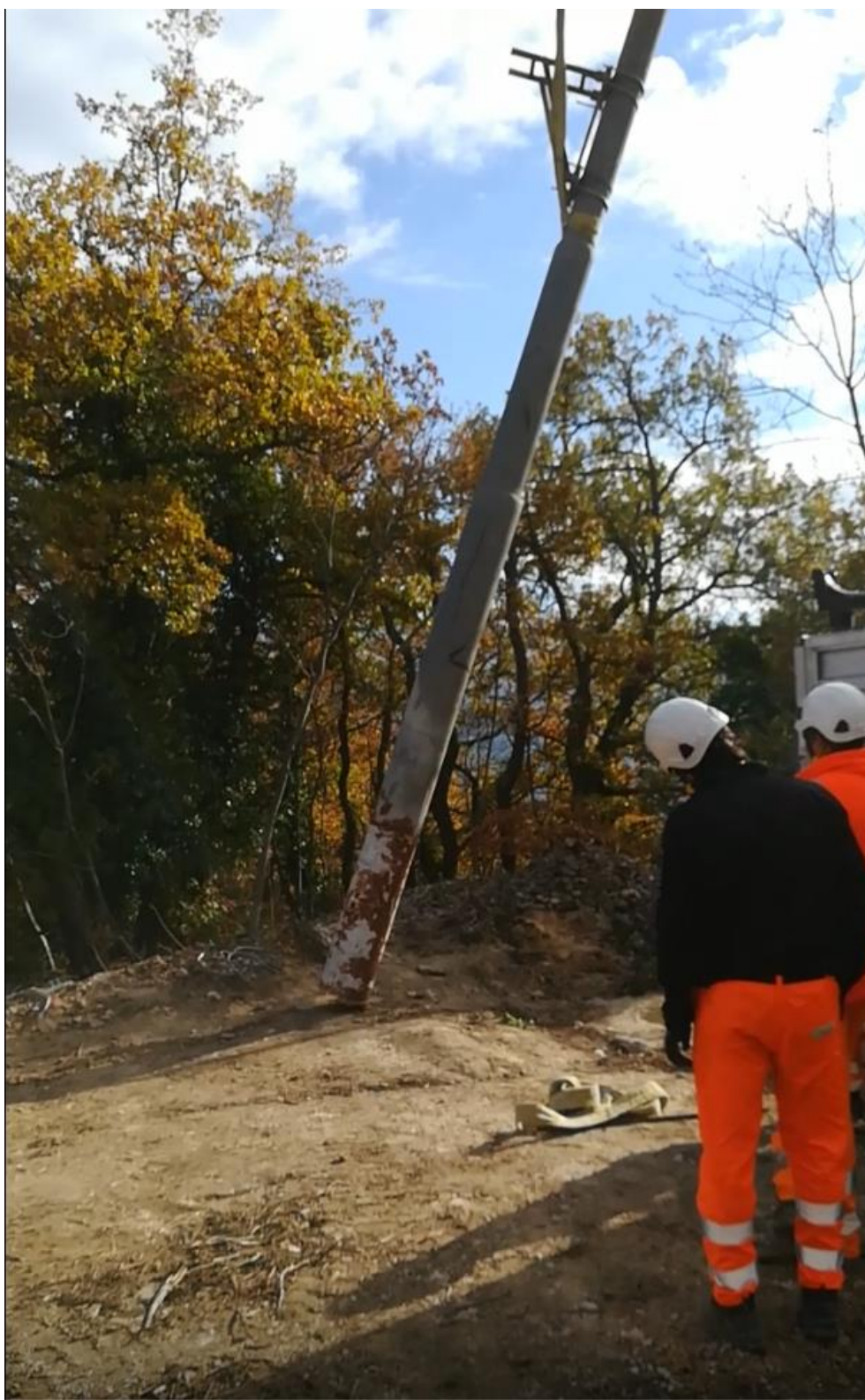
Posa sostegno e verticalizzazione
