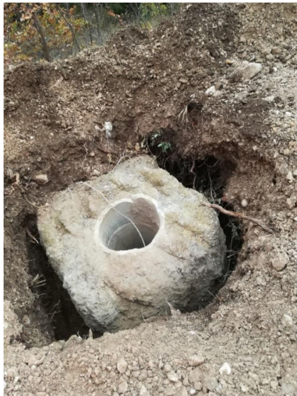
Costipamento blocco di fondazione
