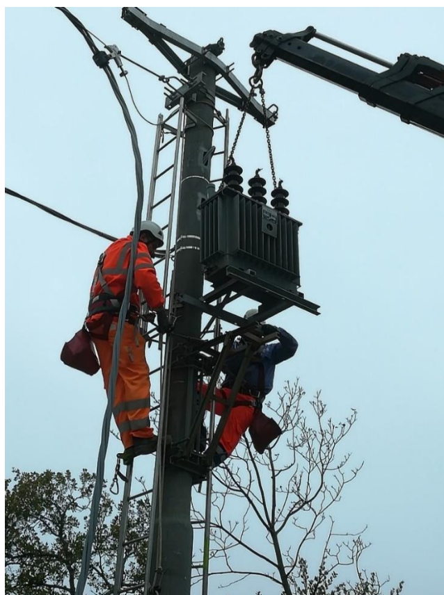
Posa trasformatore su PTP con l'ausilio di gru
