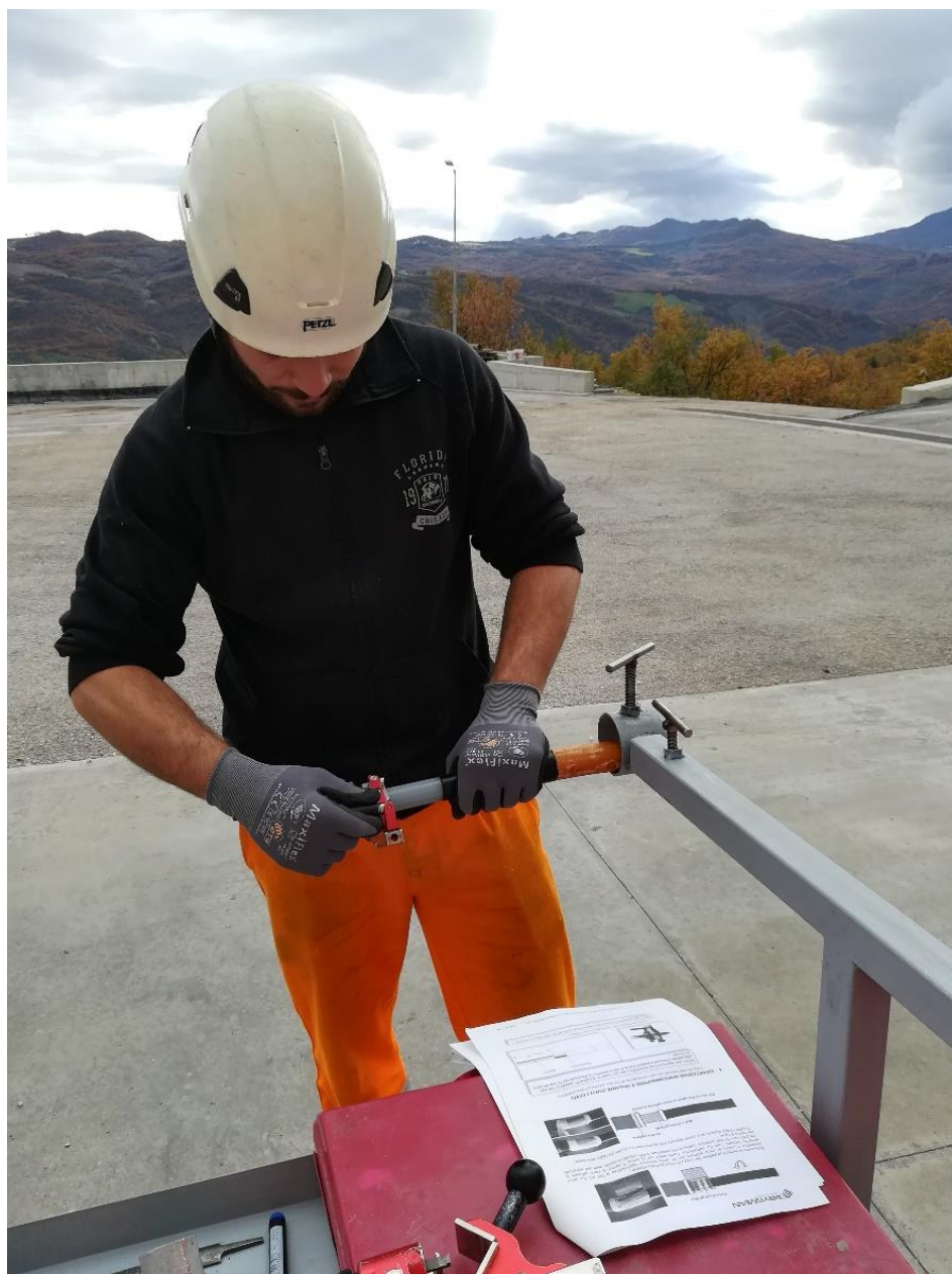
Realizzazione terminale MT
