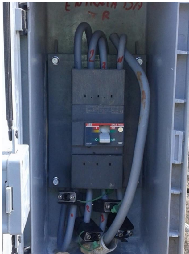
Posa interruttore per uscita BT
