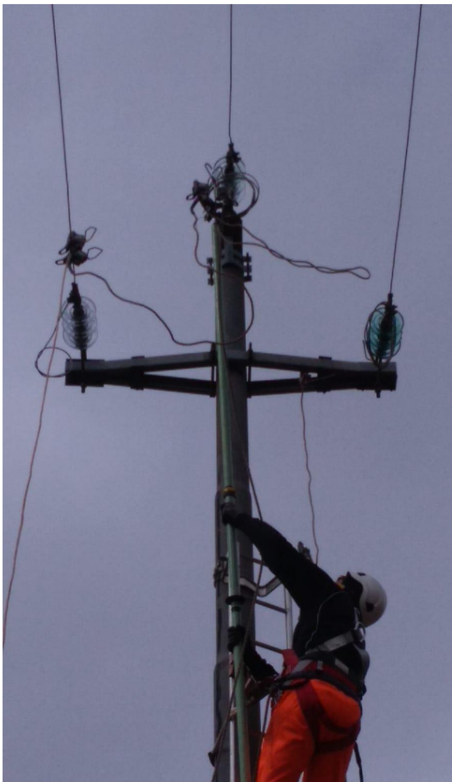
Operazioni di messa a terra, cortocircuito ed equipotenziale
