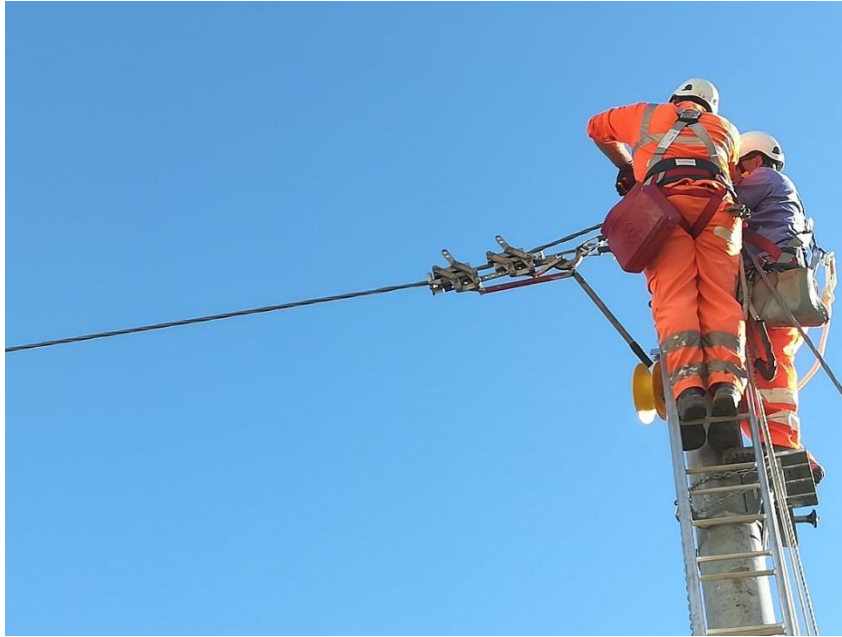
Tesatura cavo precordato BT con amarro
