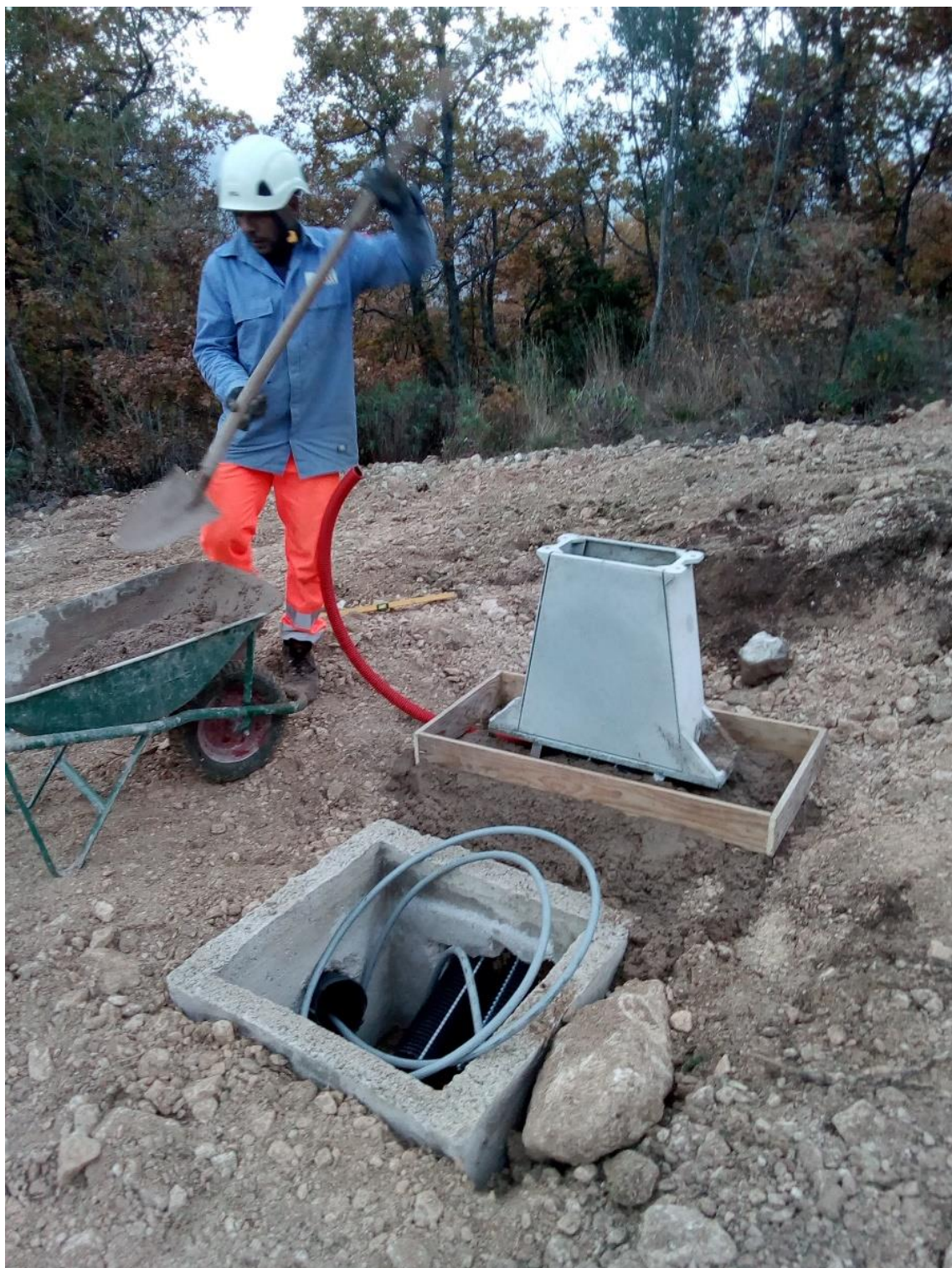
Posa nodo di derivazione C3M
