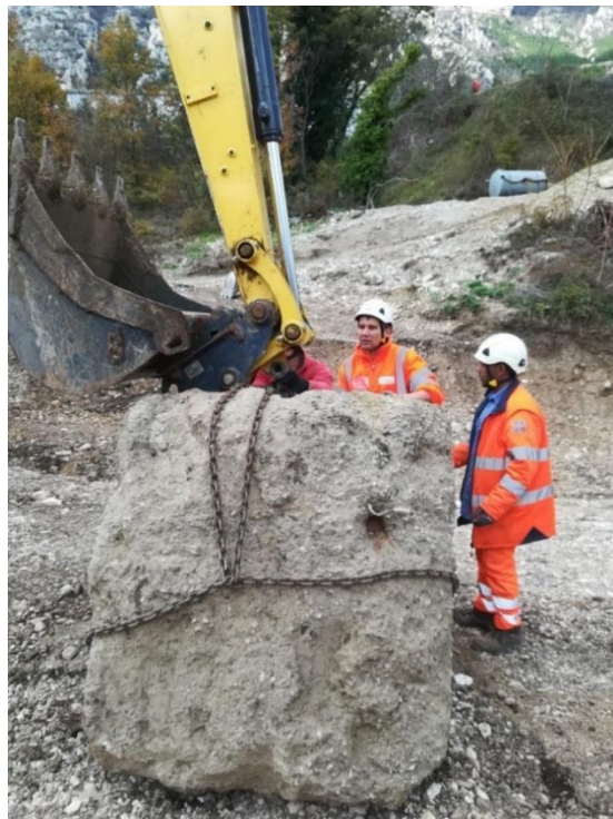
Movimentazione di blocco di fondazione prefabbricato tramite catene
