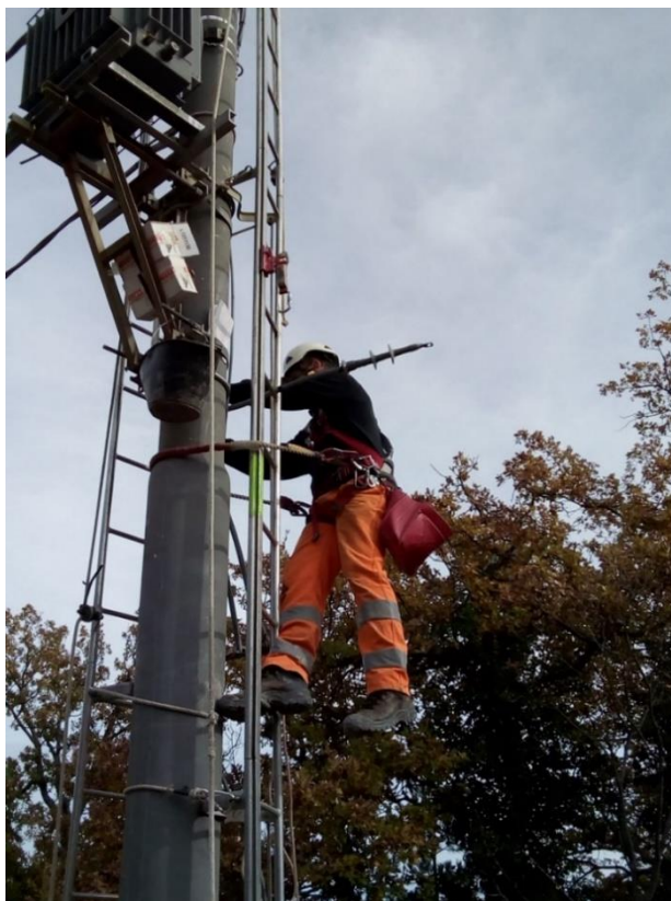
Preparazione scalata al PTP
