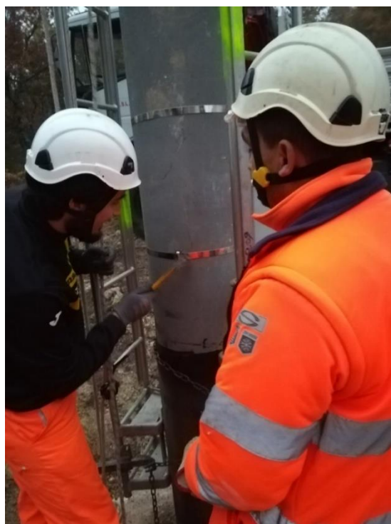
Fissaggio armadietto su PTP con nastro di acciaio tipo bandit
