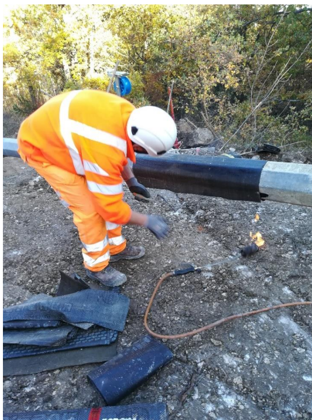
Posa guaina bituminosa su palo
