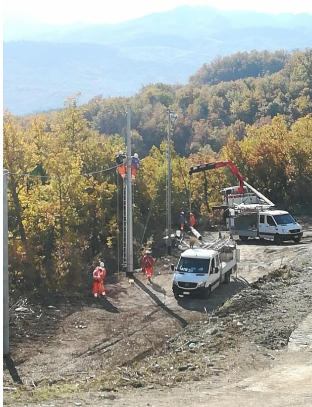
Tesatura cavo precordato BT su sostegni
