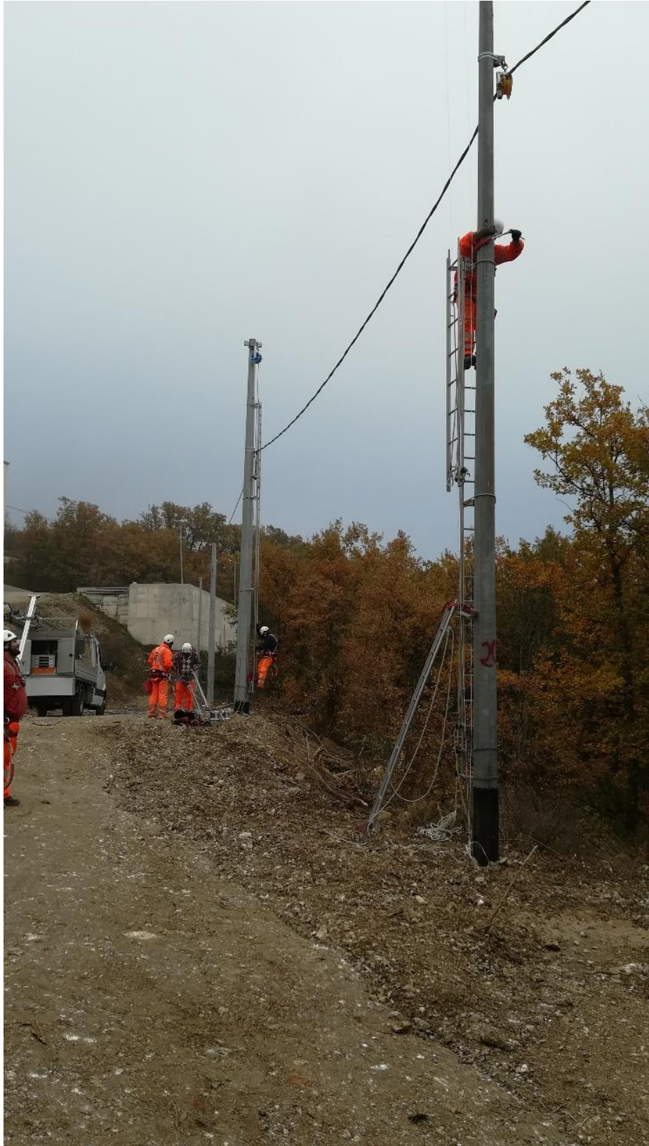
Tesatura cavo precordato BT su sostegni
