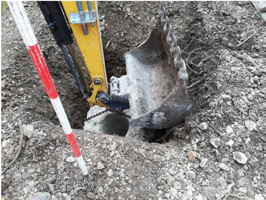
Posa blocco di fondazione con assistenza delle maestranze
