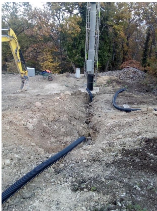
Scavo per uscita BT interrata con posa corrugato
