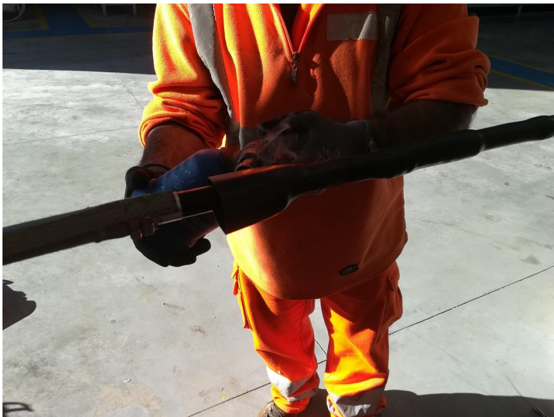
Realizzazione terminale MT
