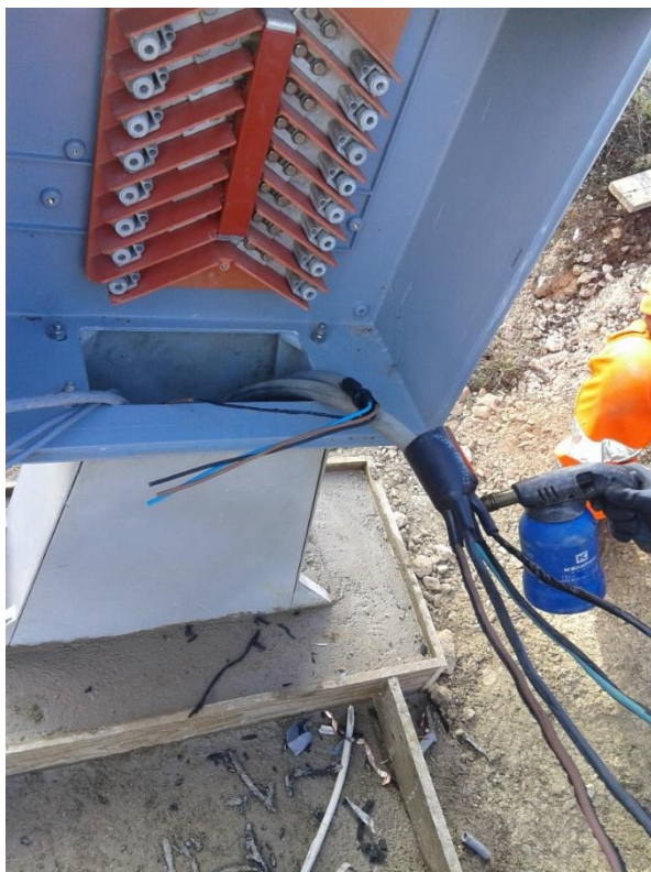
Apposizione guaina di protezione con uscita quadripolare su cavo
