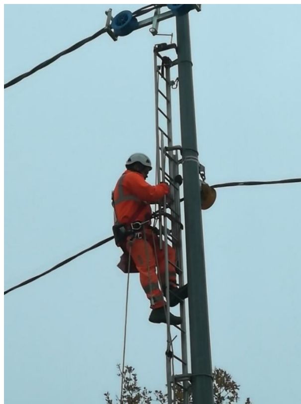
Tesatura cavo precordato BT su sostegni
