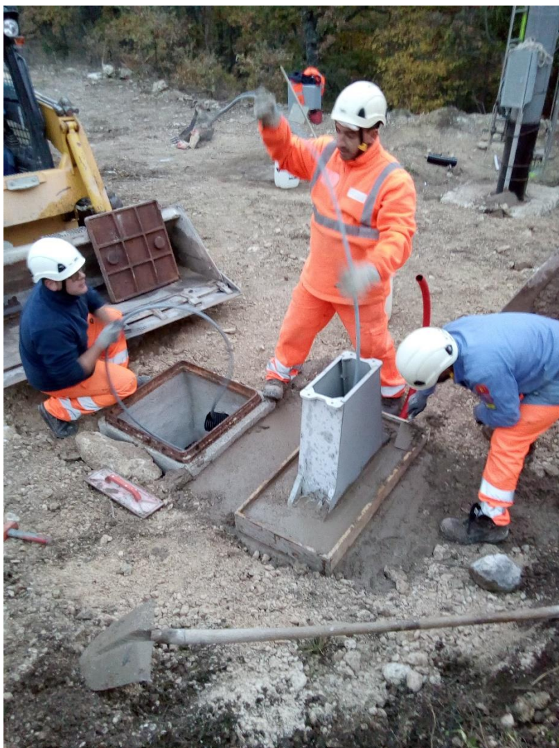
Posa nodo di derivazione C3M con infillaggio cavi BT
