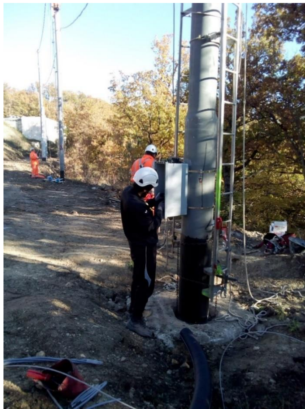
Fissaggio armadietto su PTP
