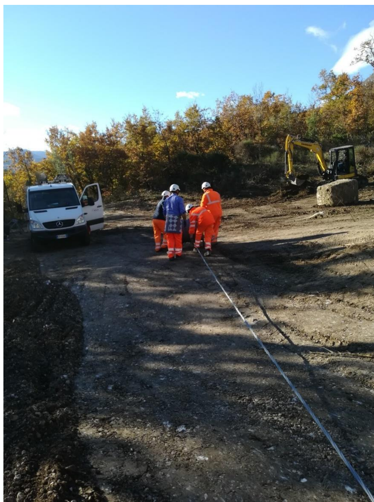
Stendimento cavo precordato BT
