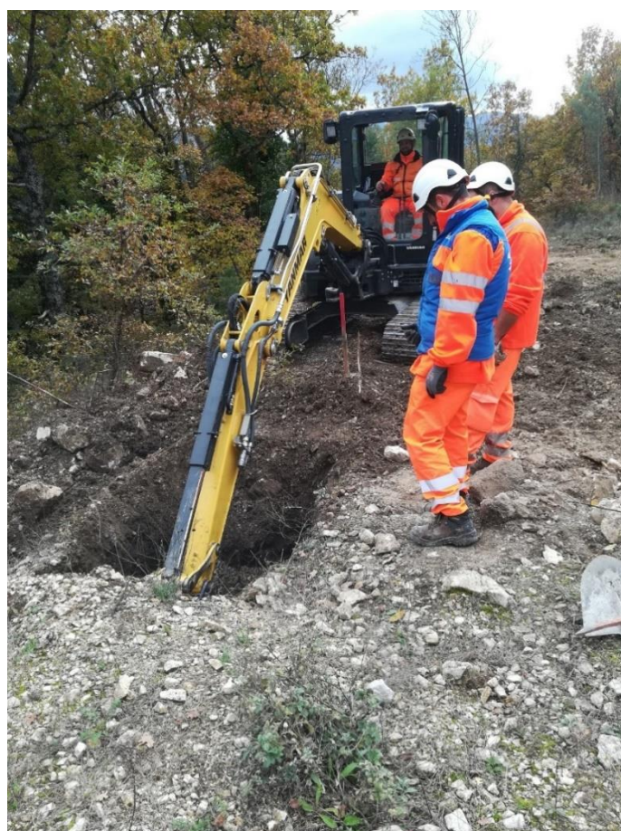
Posa blocco di fondazione con assistenza delle maestranze
