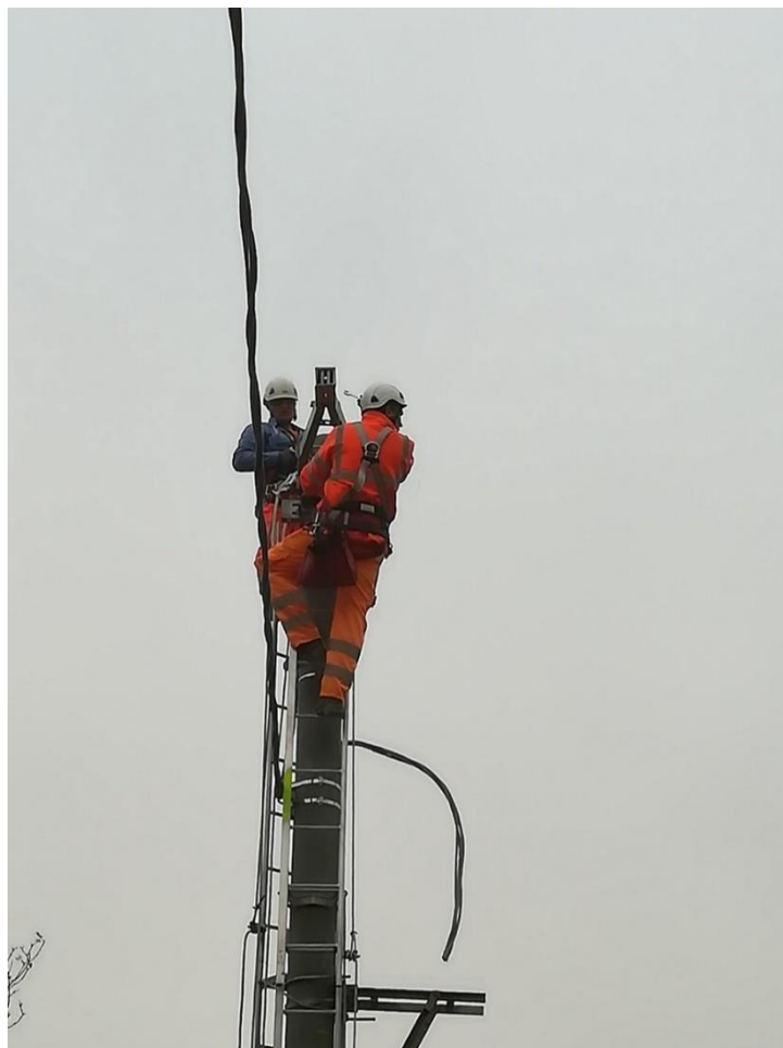
Tesatura cavo precordato BT
