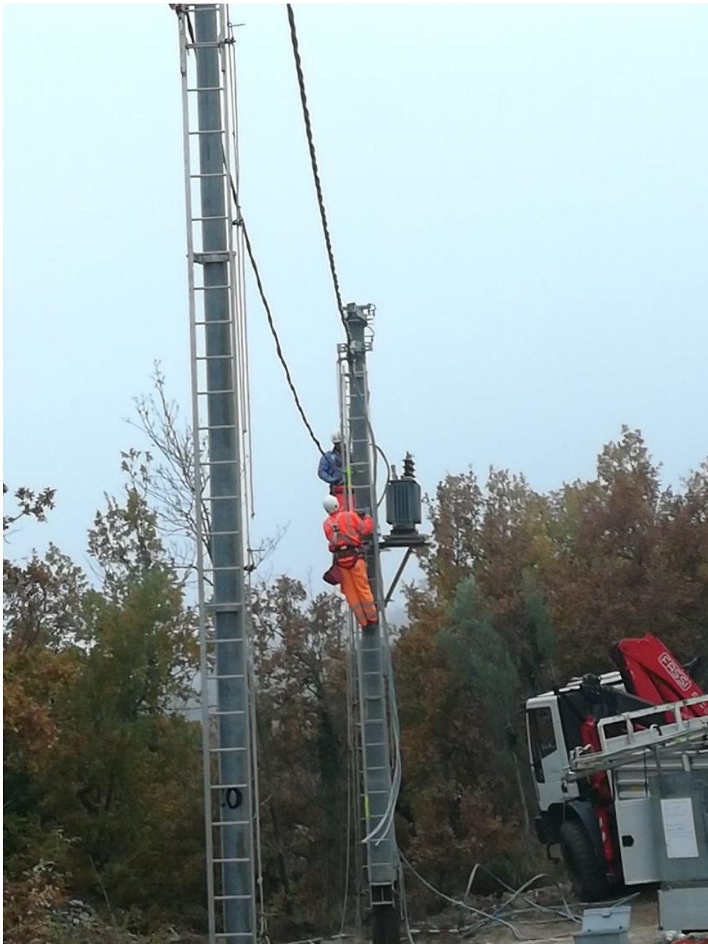
Posa trasformatore su PTP
