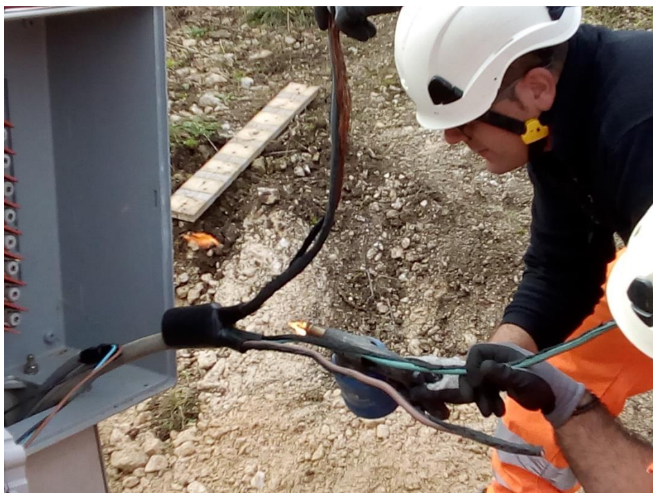
Apposizione guaina di protezione con uscita quadripolare su cavo
