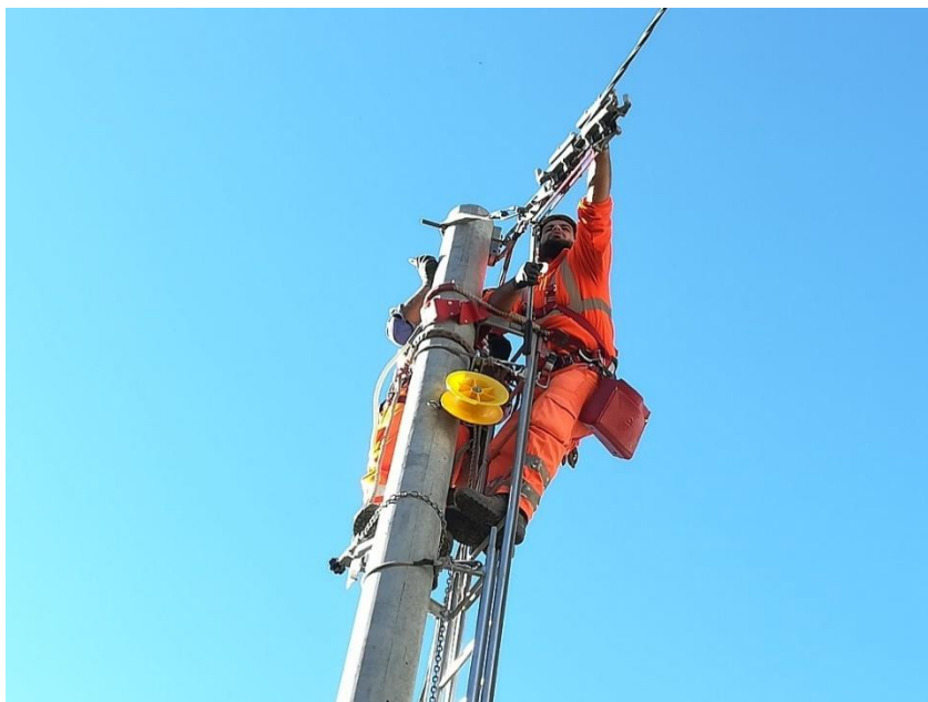
Tesatura cavo precordato BT
