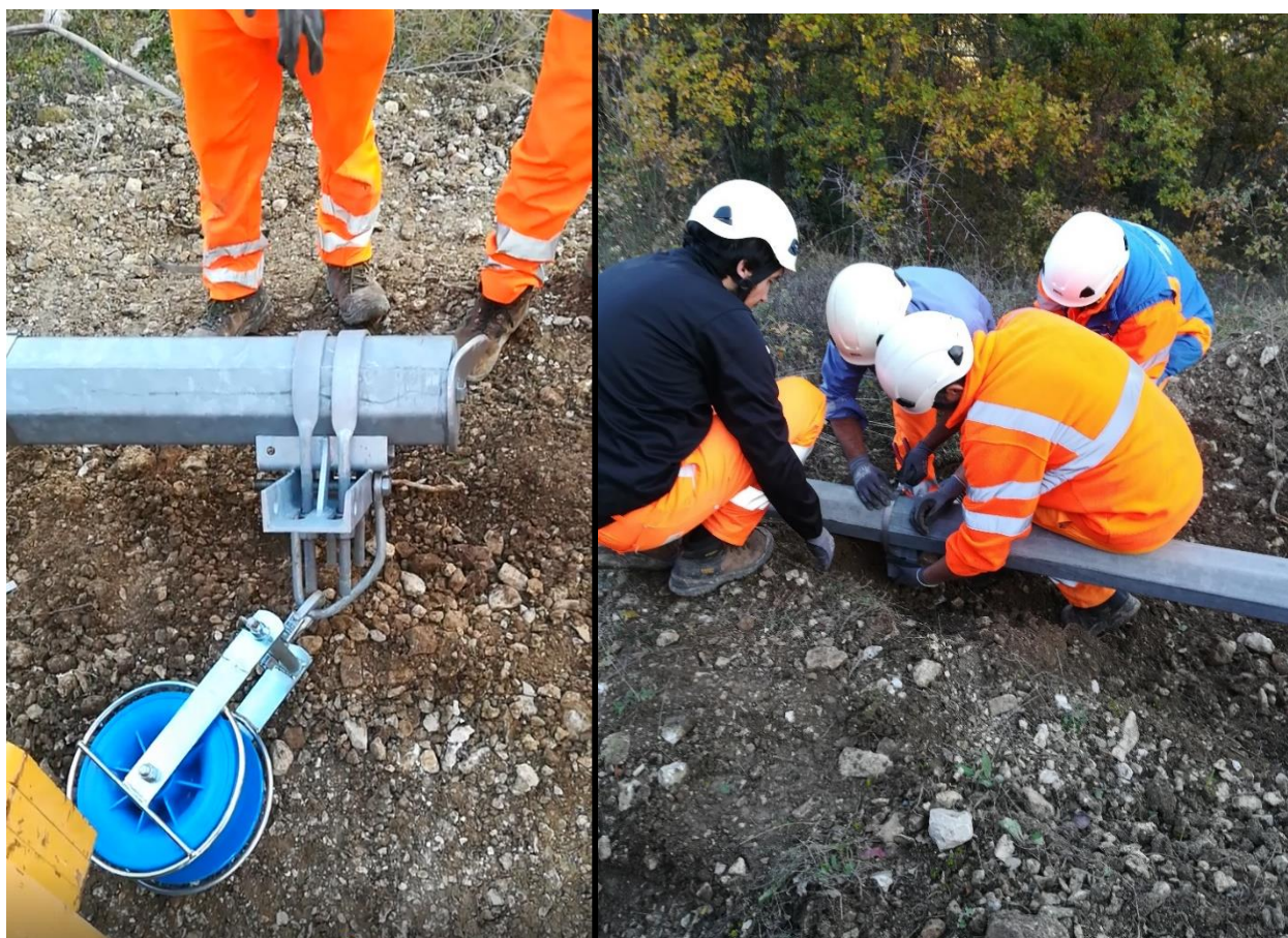
Armamento sostegno e posa carrucola
