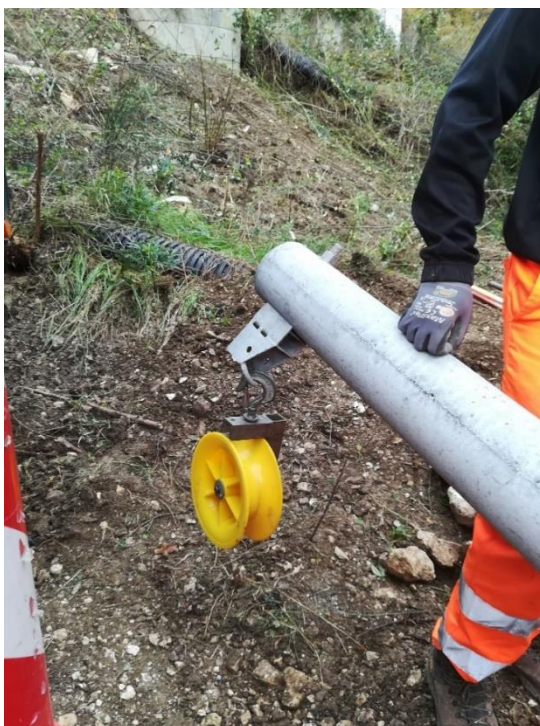
Armamento sostegno e posa carrucola
