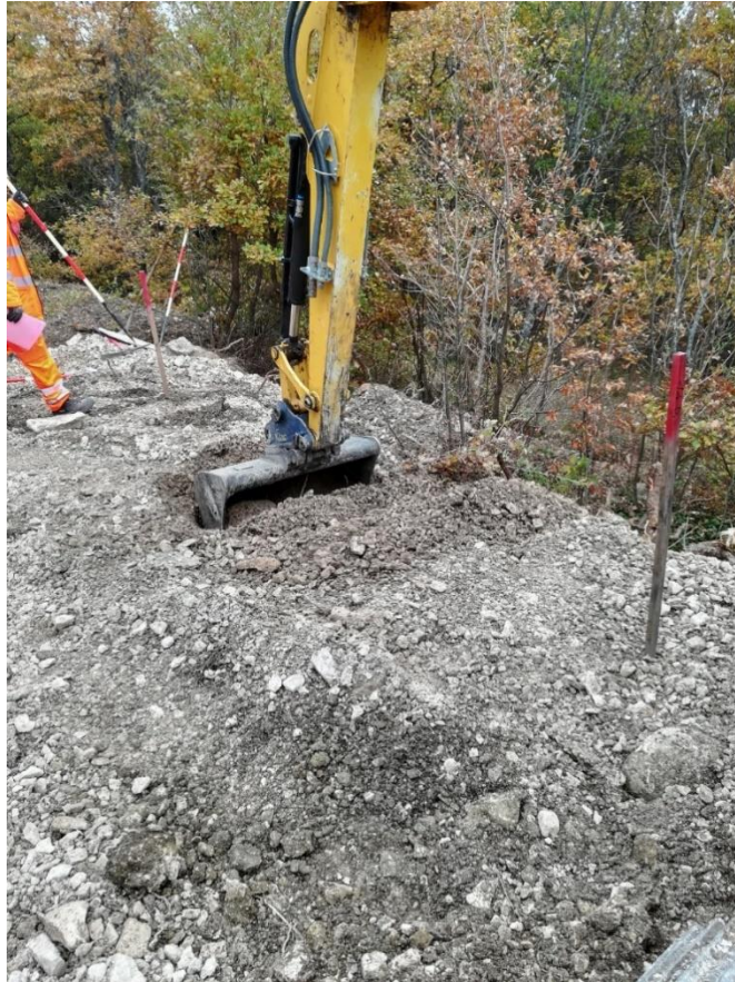
Realizzazione buca per blocco di fondazione con escavatore
