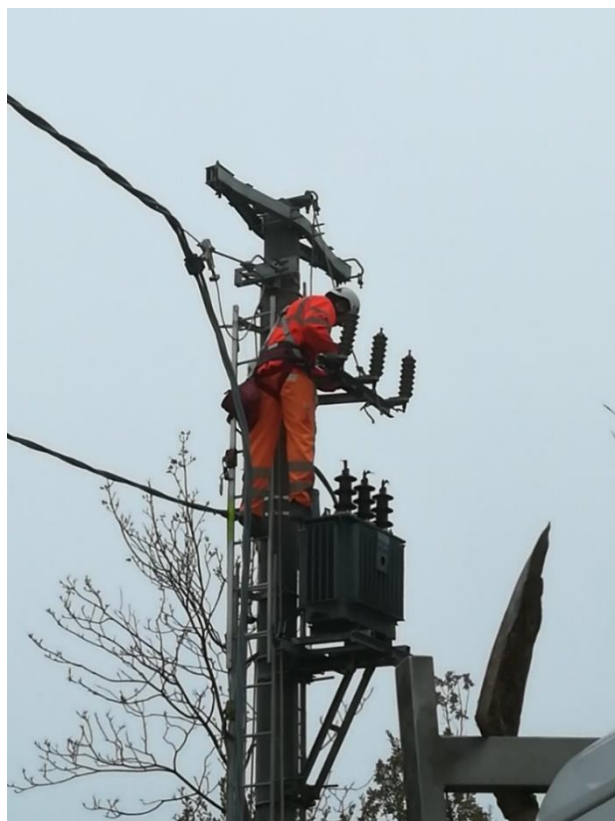
Posa scaricatori su PTP
