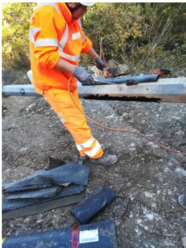
Posa guaina bituminosa su palo
