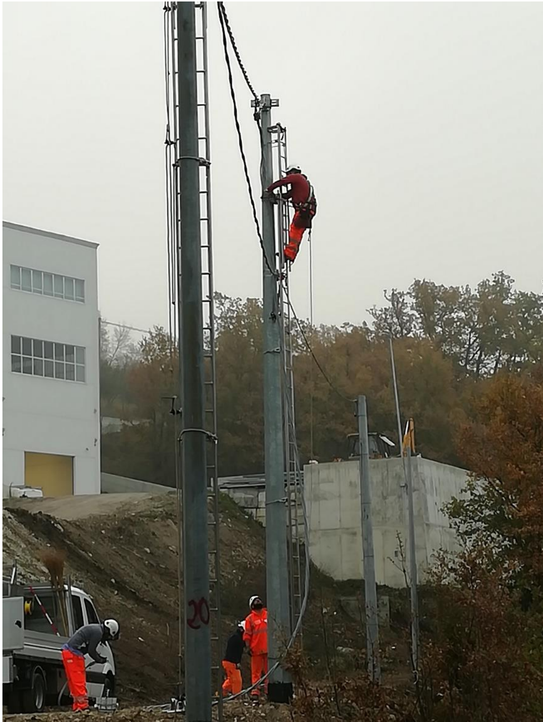
Tesatura cavo precordato BT su sostegni
