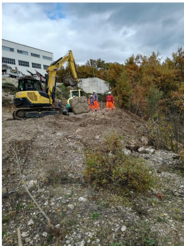
Movimentazione blocco di fondazione alla buca già realizzata
