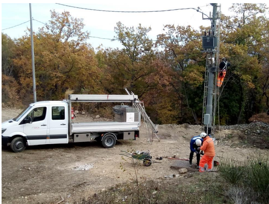
Ultimazione lavorazioni su PTP
