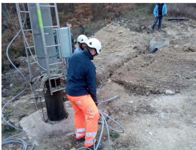
Scavo per uscita BT interrata e posa pozzetto
