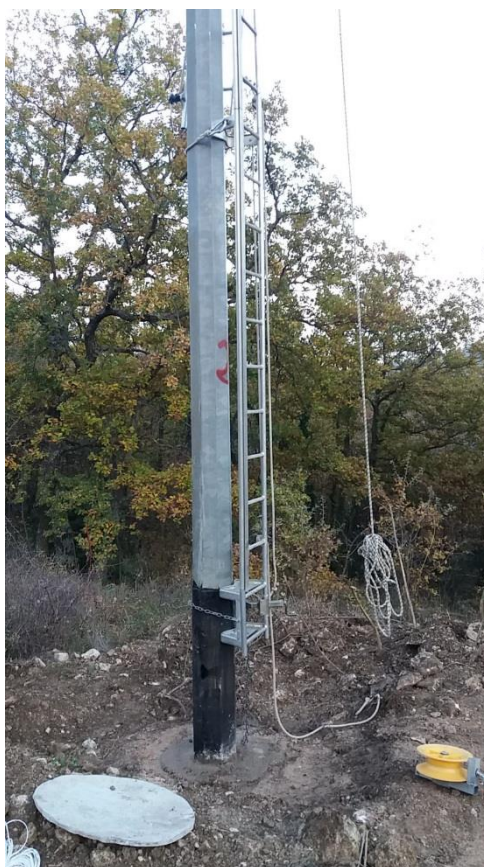
Montaggio scala per scalata sostegno
