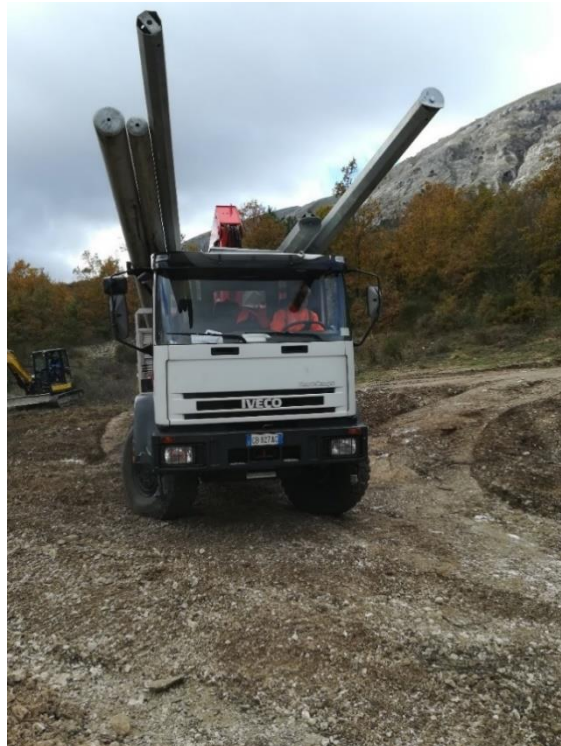
Trasporto pali presso cantiere
