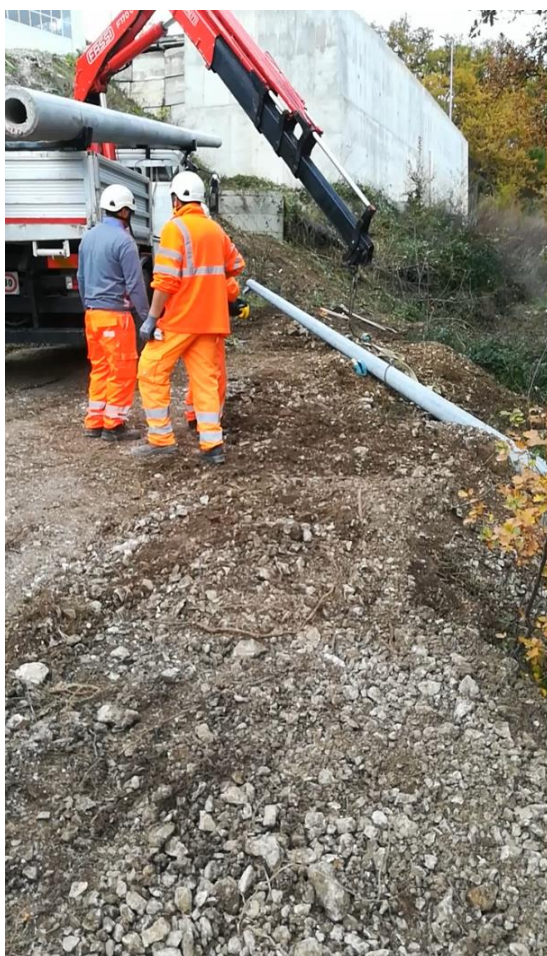
Innalzamento palo con gru
