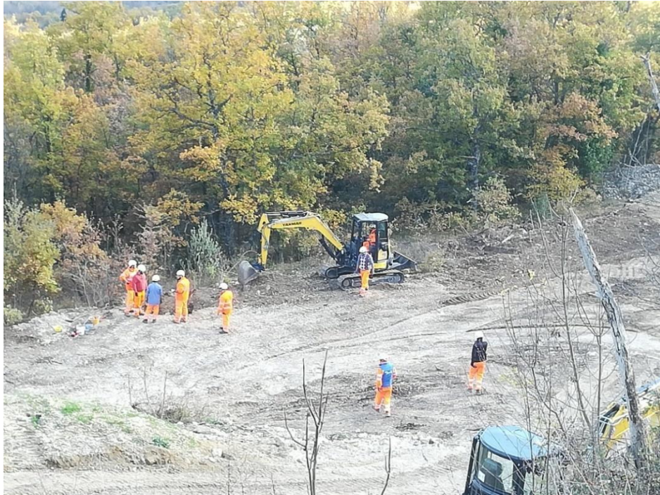
Preparazione del cantiere
