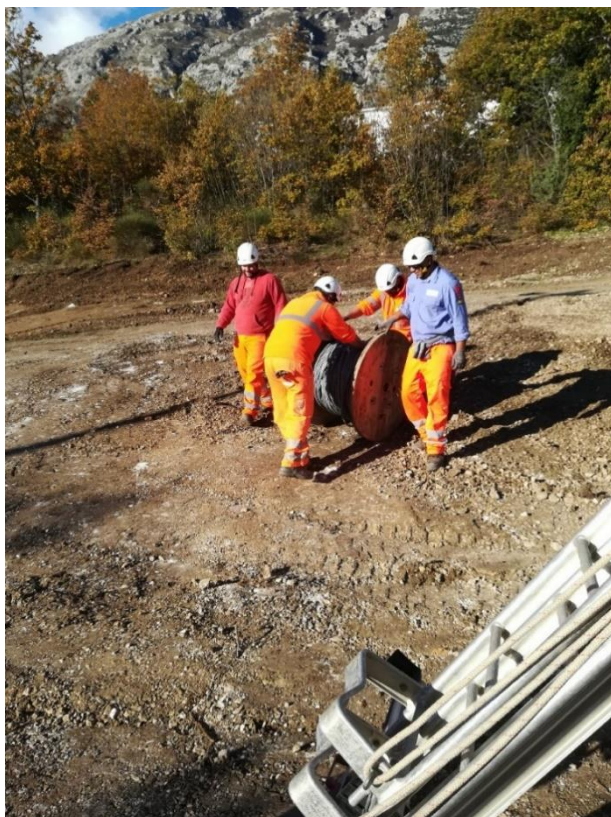
Avvicinamento bobina di cavo precordato BT a sostegno
