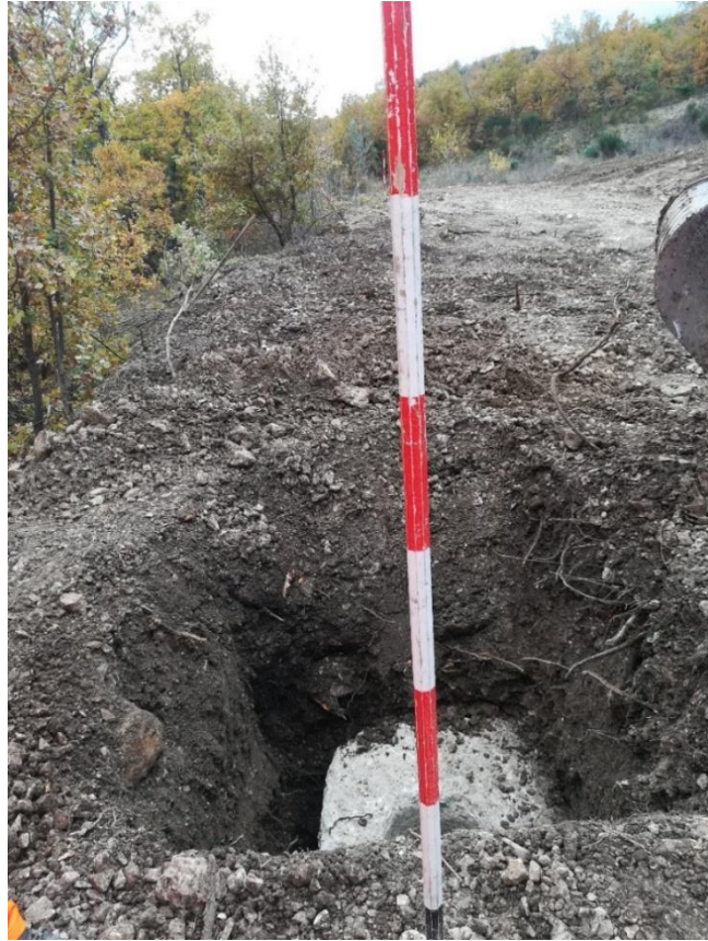
Costipamento blocco di fondazione con allineamento
