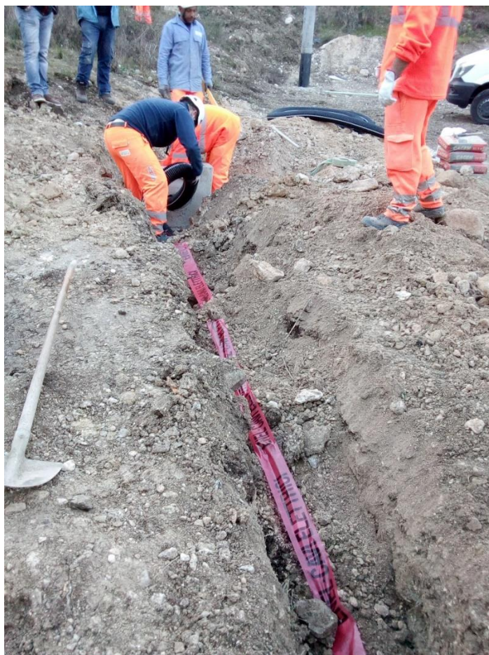
Scavo per uscita BT interrata con posa nastro segnalatore
