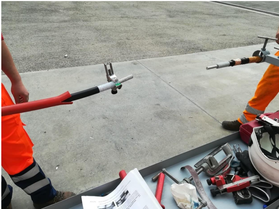
Realizzazione terminale MT – asportazione isolante
